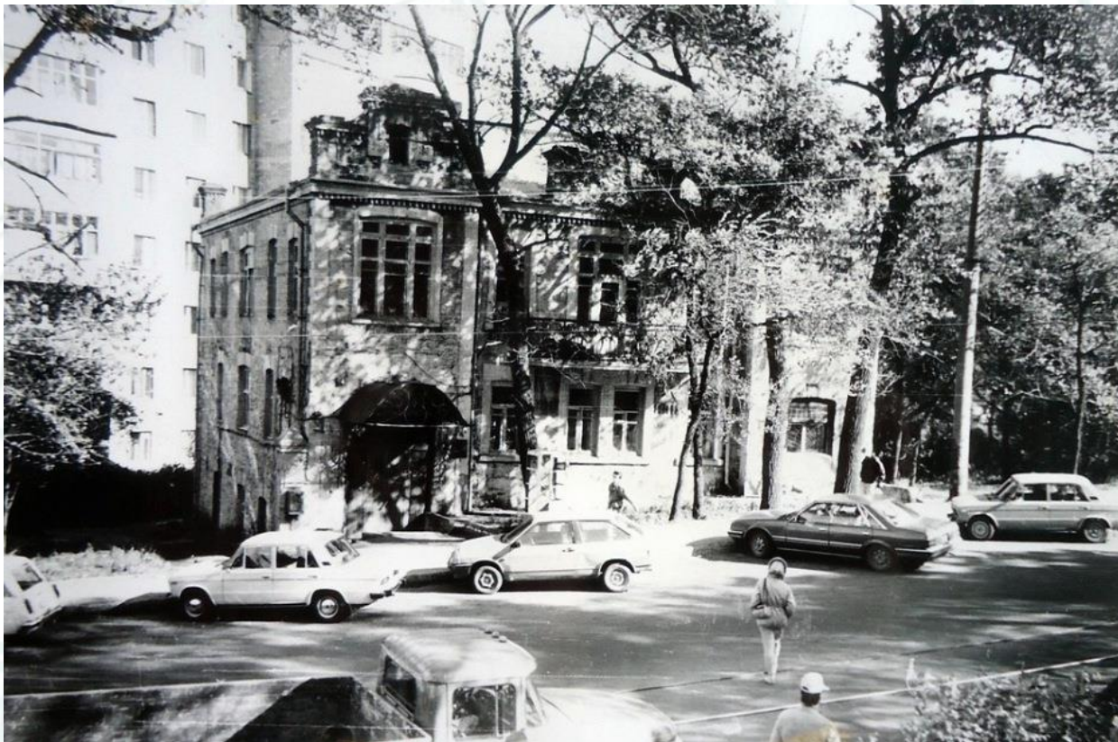
Дом В.Глуздовского, фото конца 80-х. Владивосток , просп. Острякова, 24 памятник архитектуры (истории), строение 1906 года
